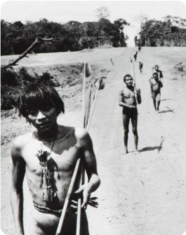
Indígenas lanomâmis na construção da rodovia federal BR210, conhecida como Perimetral Norte, em 1975. Foto (Acervo ISA-Bruce Albert/reprodução)
